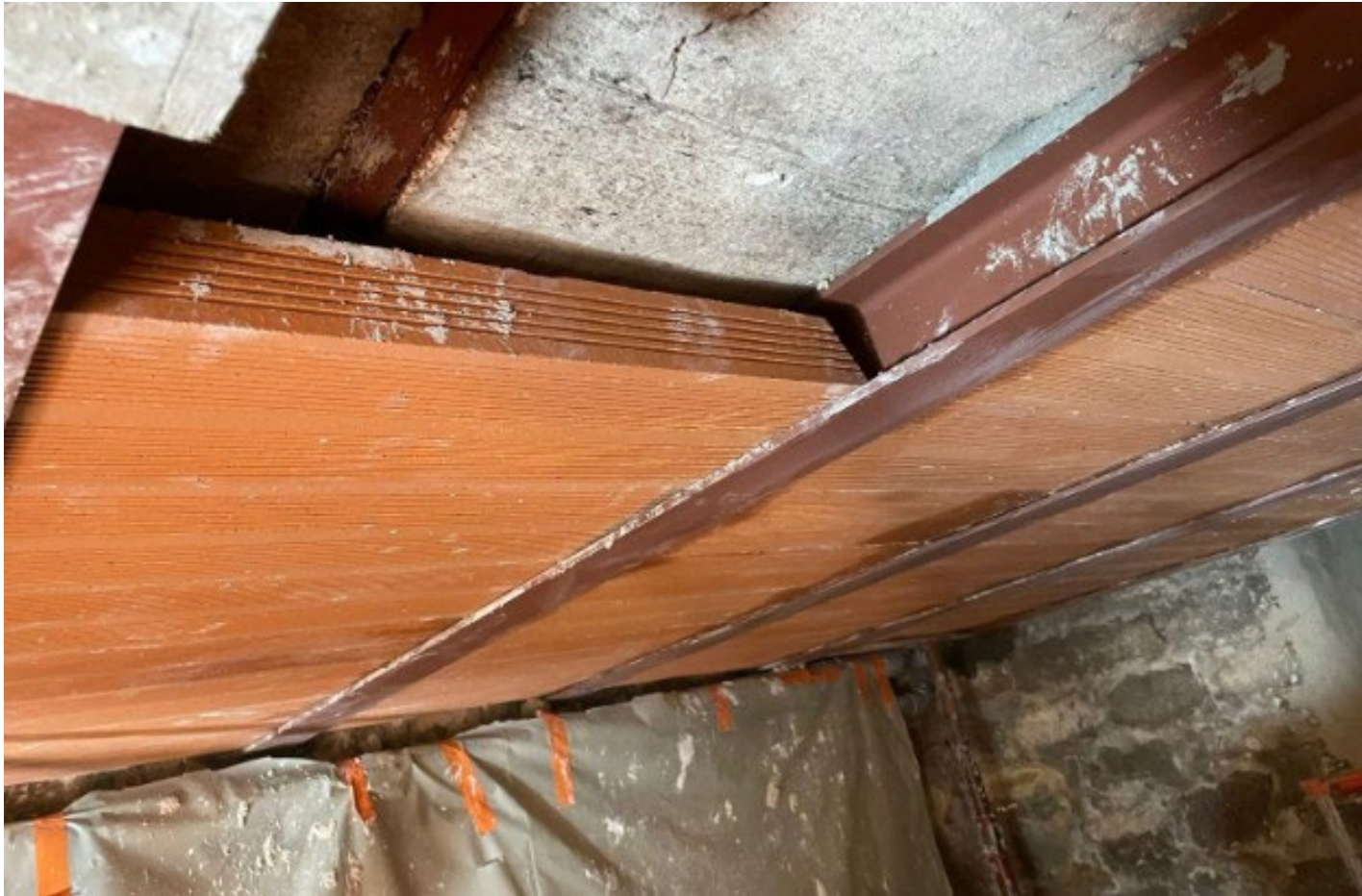
Renforcement par plancher à l'italienne
